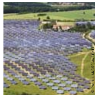
Bild PHOTOVOLTAIK-ANLAGE DER FIRMA SOLON AG IN ARNSTEIN, DEUTSCHLAND. 1500 HORIZONTALE UND VERTIKALE „SOLARMOVER“ WERDEN BEWEGT.
