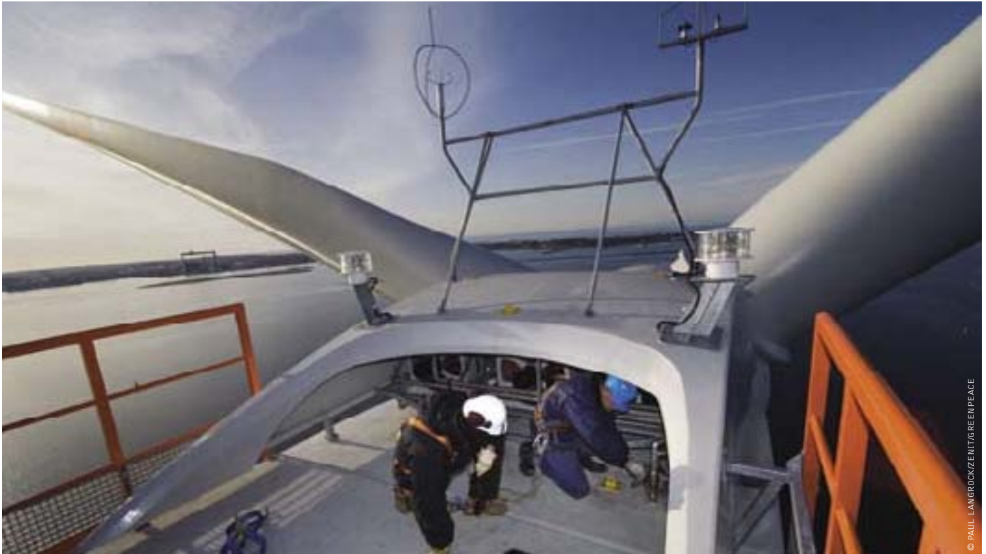
Bild TEST-WINDDRAFTANLAGE N90 2500, GEBAUT VON DEM DEUTSCHEN UNTERNEHMEN NORDEX IM HAFEN VON ROSTOCK. DIESE WINDKRAFTANLAGE PRODUZIERT 2,5 MEGAWATT UND WIRD UNTER OFFSHORE-BEDINGUNGEN BETRIEBEN. MINDESTENS 10 SOLCHER ANLAGEN WERDEN BIS 2007 20 KM VOR DER INSEL DARSS IN DER OSTSEE ERRICHTET. ZWEI TECHNIKER ARBEITEN IM INNEREN DER TURBINE.
