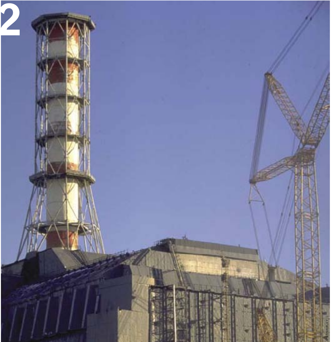
Abb: ATOMKRAFTWERK TSCHERNÓBYL, UKRAINE
